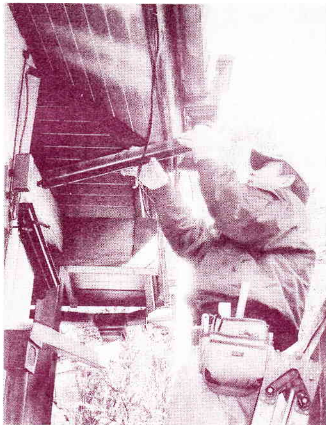
↑施工しているのは軽野板金です。
