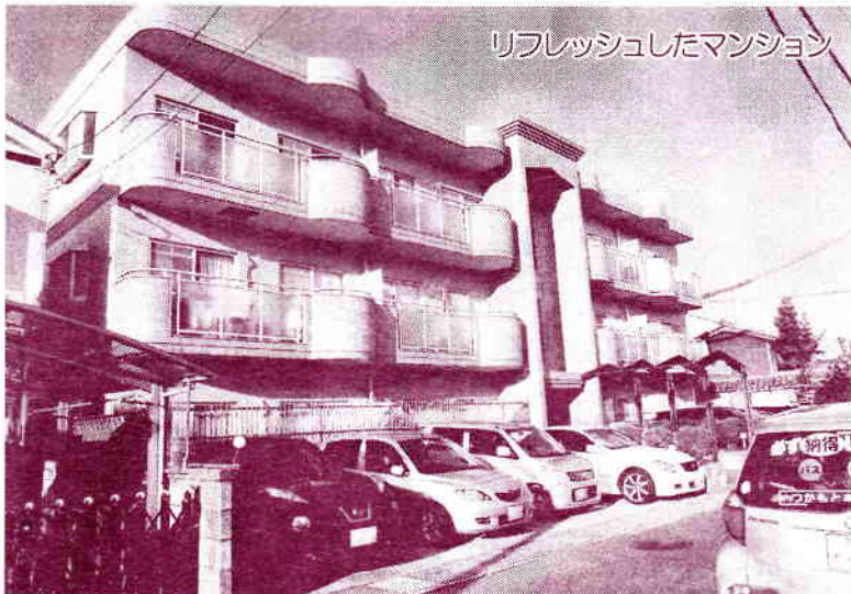
↑ 浮きのあったバルコニーの壁面タイルを解体した後です。
