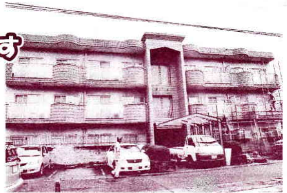
↑ 仕事のかかり始めの足場をかけているところです。
